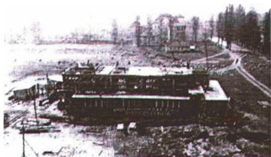
Aspect din faza de construcție
